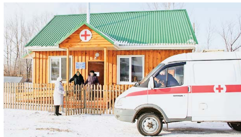
Новое здание ФАПа вписалось в алтайский пейзаж
